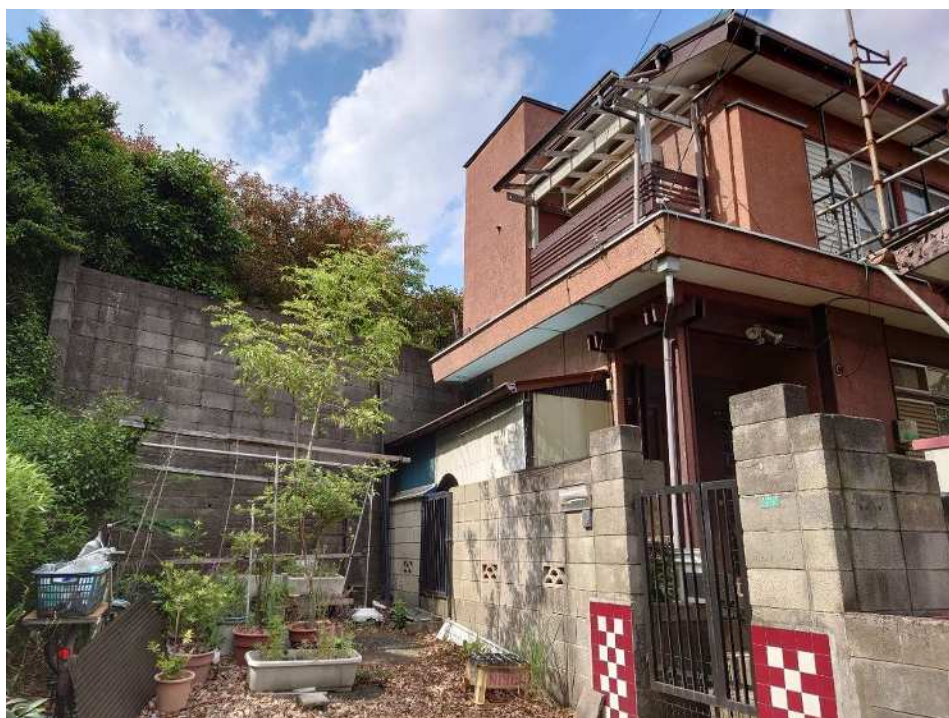
[写真① 建物南西側]
