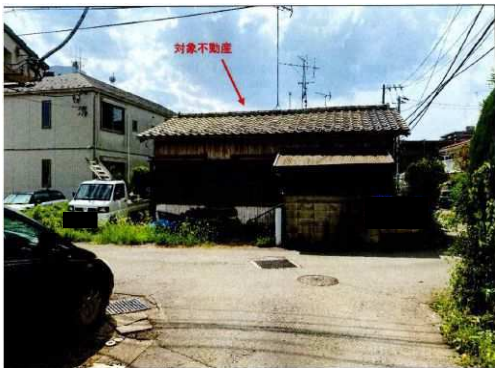
[写真④建物東側から]
