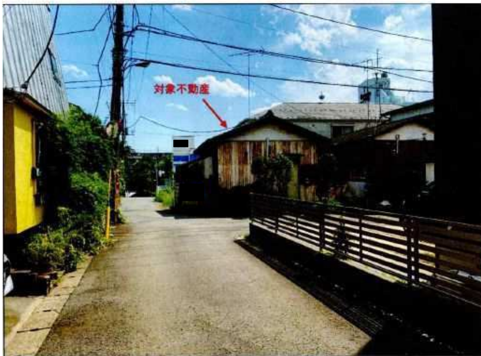
[写真①建物北東側から]
